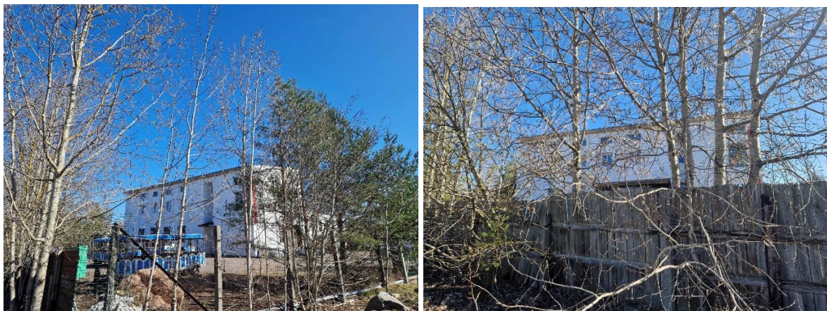
Fotod 1 ja 2. Elektroni tn 7 autoremonditöökoda
